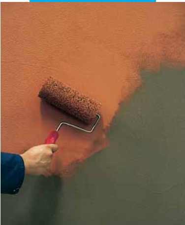
Esempio di applicazione di Elastocolor Rasante con rullo di spugna alveolare
