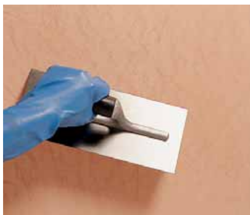
Effetto veneziano: lucidatura di Silexcolor Marmorino con taloscia d'acciaio tenuta a filo
