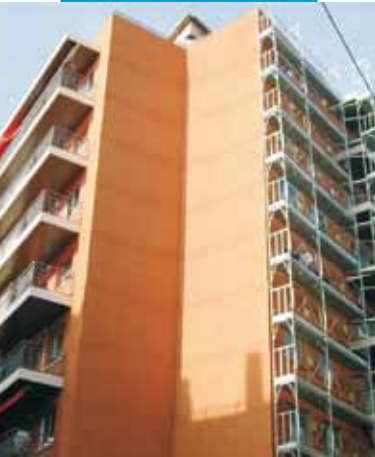
Esempio di applicazione di Quarzolite Tonachino in un edificio privato in Figueras - Spagna
